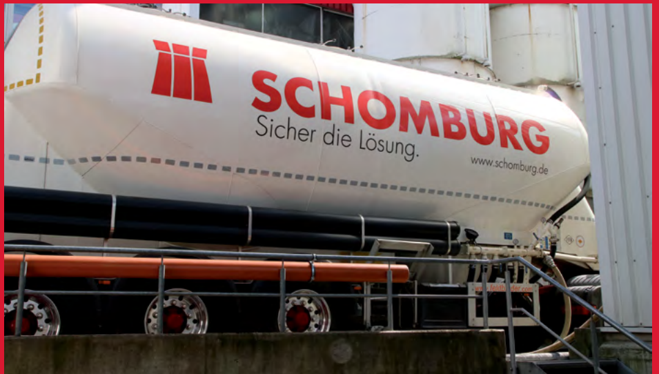
Im Schnitt kommen täglich fünf große Lkw auf den Hof, um Quarzsande, Zemente und andere Rohstoffe zu entladen. Etwa 125 Tonnen gehen auf diese Weise jeden Tag in die Silos.
